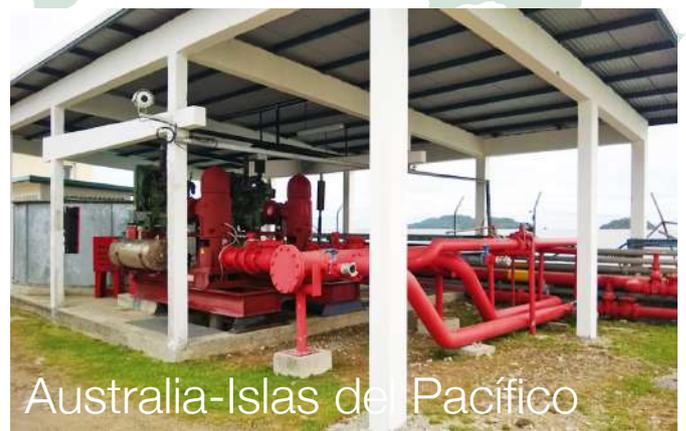
En este caso, hemos colaborado con nuestro socio en la realización de un sistema contra incendios que funciona con agua de mar. El grupo de presurización consta de dos bombas resistentes al tipo de líquido y alimentadas por un motor diésel, lo que garantiza la máxima fiabilidad de funcionamiento.
