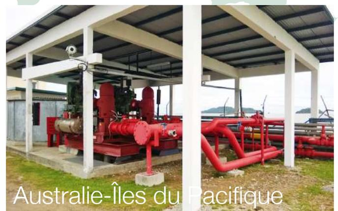
Dans ce cas, nous avons assisté notre partenaire dans la réalisation d'un système anti-incendie fonctionnant avec de l'eau de mer. Le groupe de pressurisation est composé de deux pompes résistantes au type de liquide et alimentées par un moteur diesel, en mesure d'assurer une fiabilité opérationnelle maximale.
