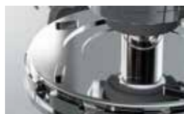
Limpieza del rodete y protección de los cojinetes
